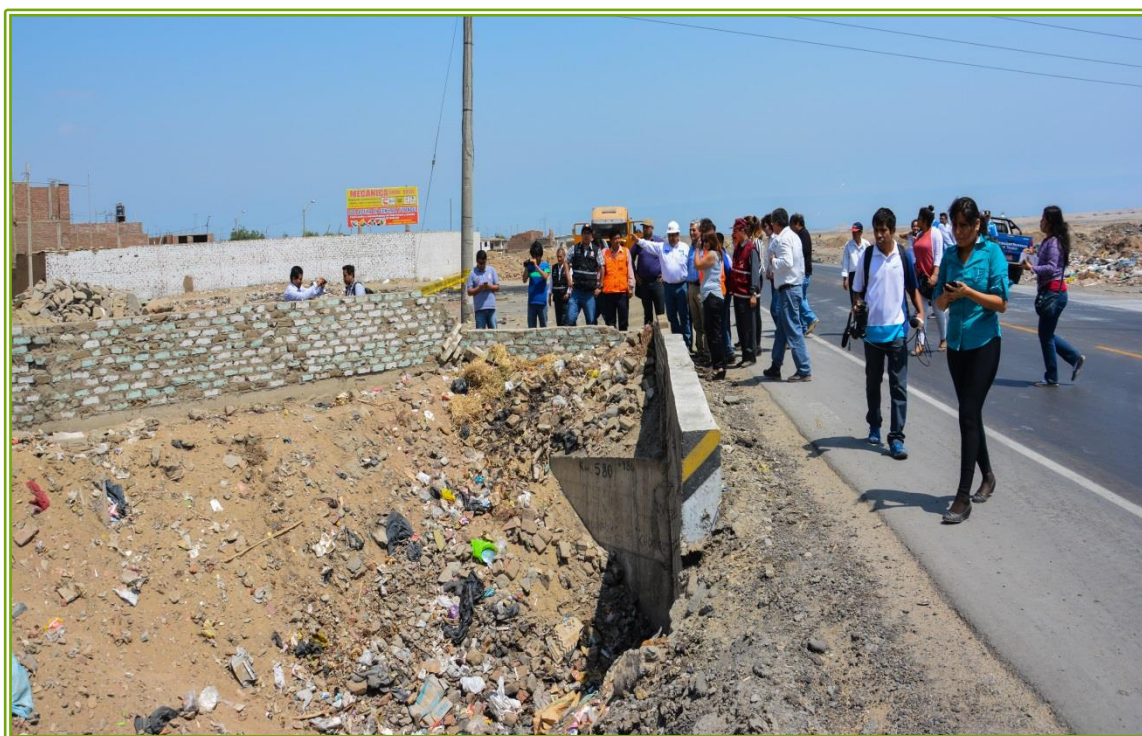
Informando al Alcalde de la MPT Elidio Espinoza sobre los trabajos a realizar posteriormente
