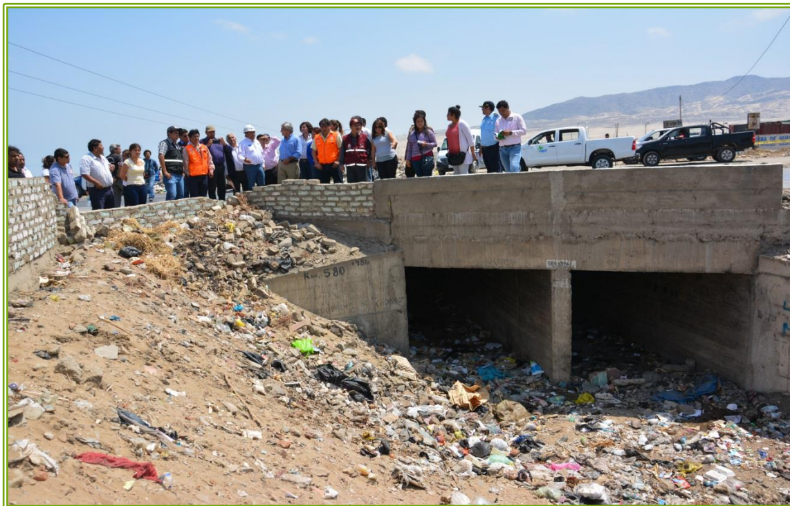
Alcantarilla obstruida de la Quebrada de León
