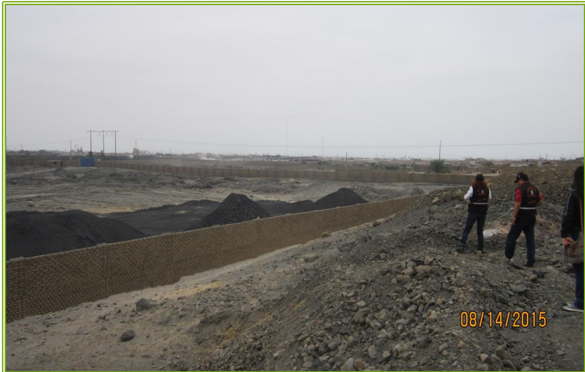
Presencia de Carboneras en pleno cauce de la Quebrada de León
