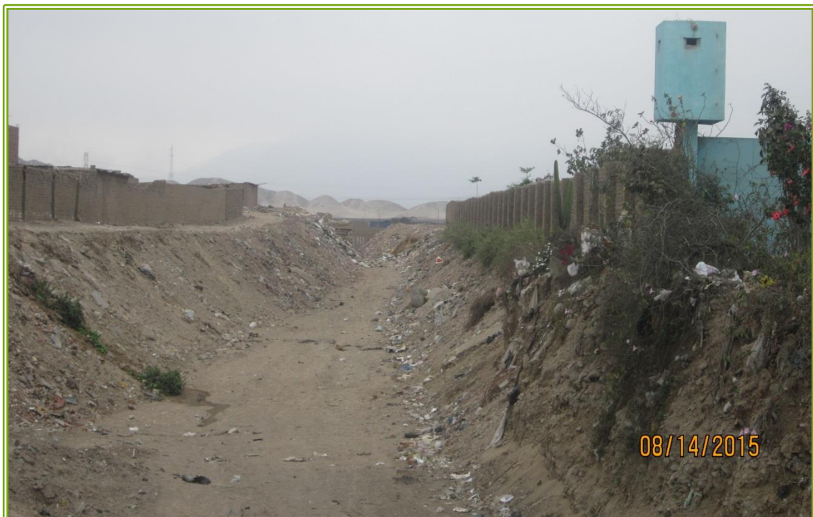
Pequeño tramo del cauce que aún no está invadido por construcciones de viviendas
