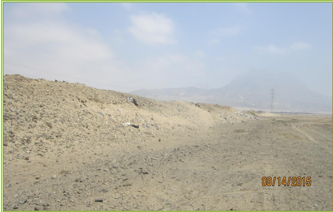
Nueva vista del Muro Incaico, observándose la pendiente del terreno
