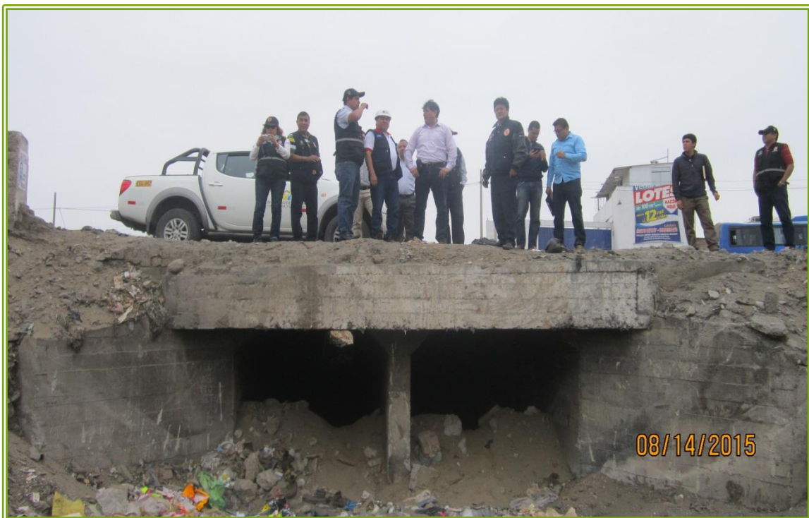
Alcantarilla de la Quebrada de León obstruida
